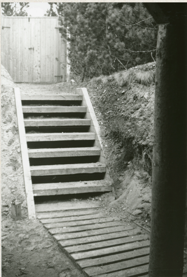
Foto: Nedgangen til skydeskuret, 1946 - 1949
