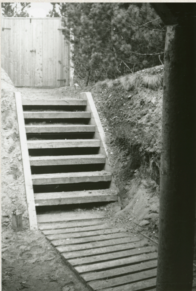
Foto: Nedgangen til skydeskuret, 1946 - 1949
